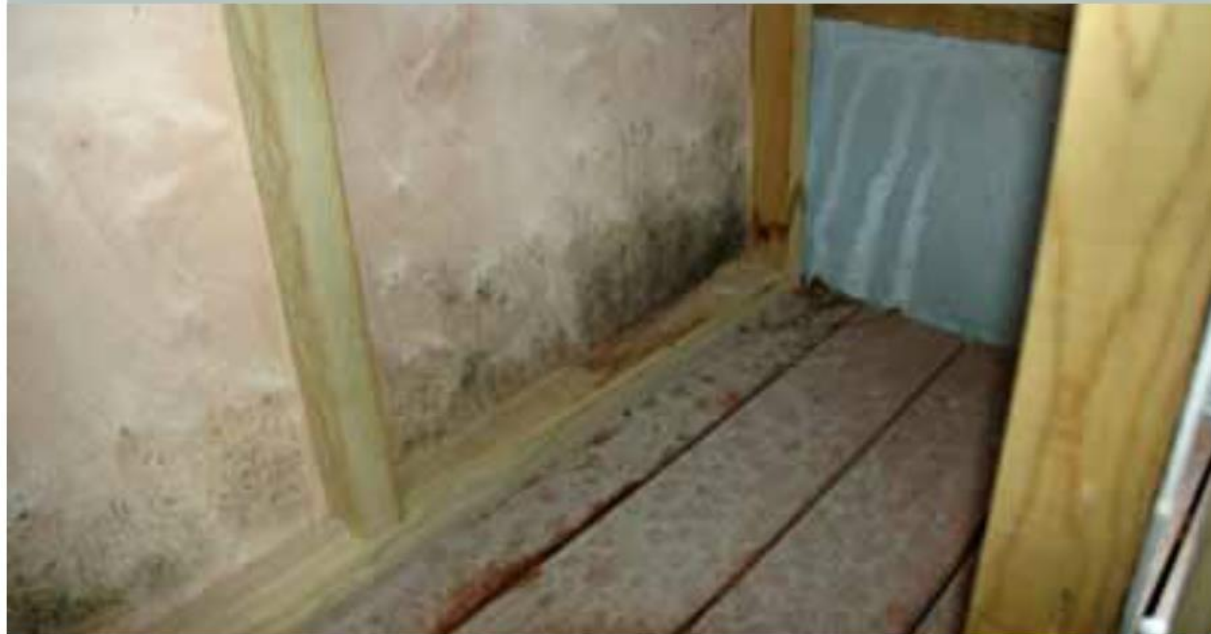
Skimmelsvamp i terrasseskuret - endnu før lejligheden er solgt.
