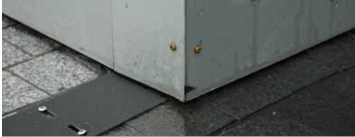
Formentlig galvaniserede skruer i aluminium - det betyder rust.
